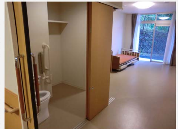
トイレのドアはスライドと開閉の両方ができ、非常に機能的なつくりになっている
